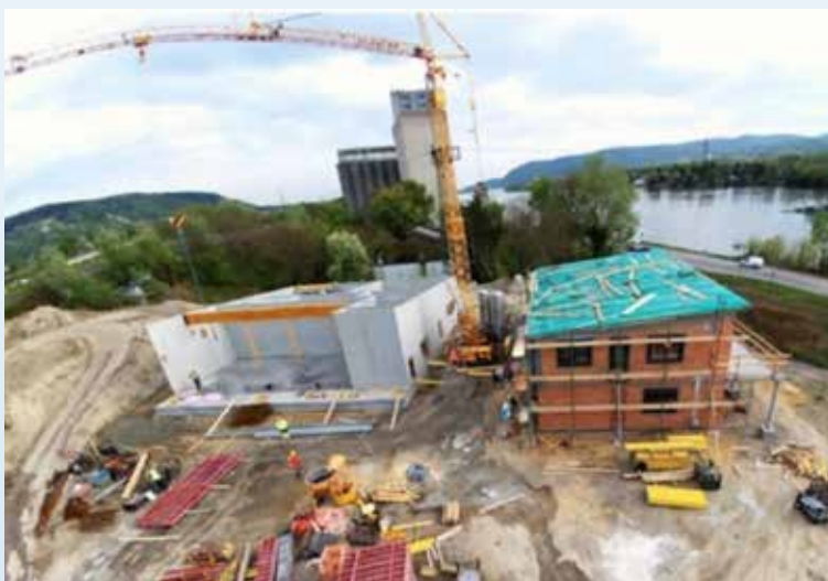
Bild: Baustelle ARA (Luftbild Juni 2017)
