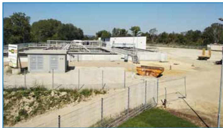
Foto 1: Blick zur neuen Kläranlage vom Betriebsgebäude
