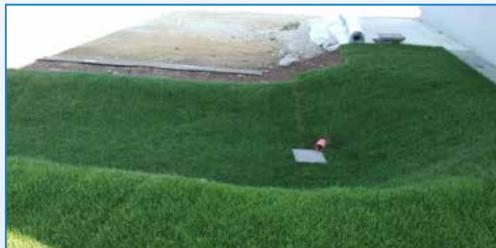
Foto 2: Versickerungsmulde für Oberflächenwasser
